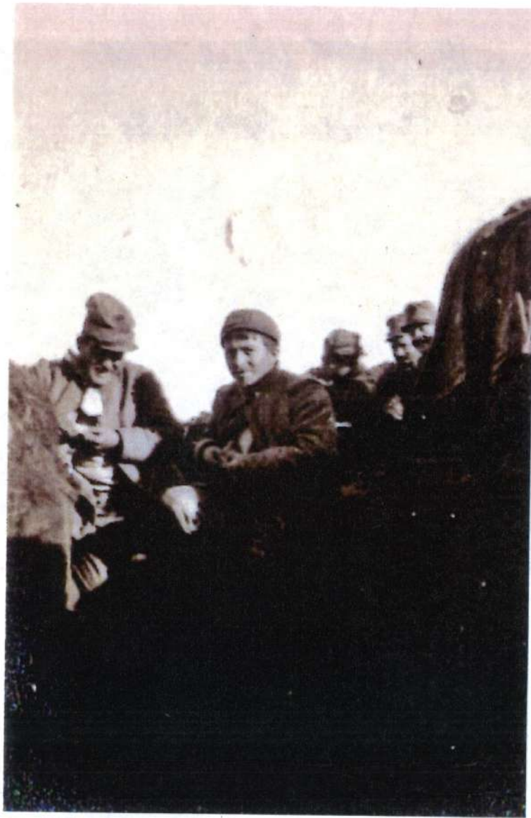
PRIMA LINEA - TRINCEA DELLE CELLE
